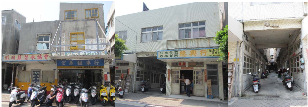
圖 3-8 規劃範圍沿街面商業使用現況照片
